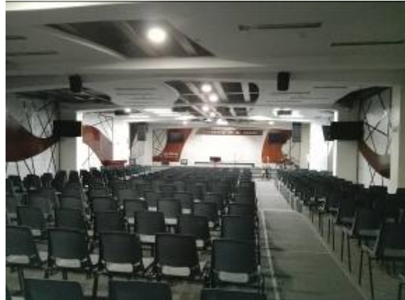
Fotografía No. 4 Ubicación de las fuentes electroacústicas y alfombrado del Salón.
